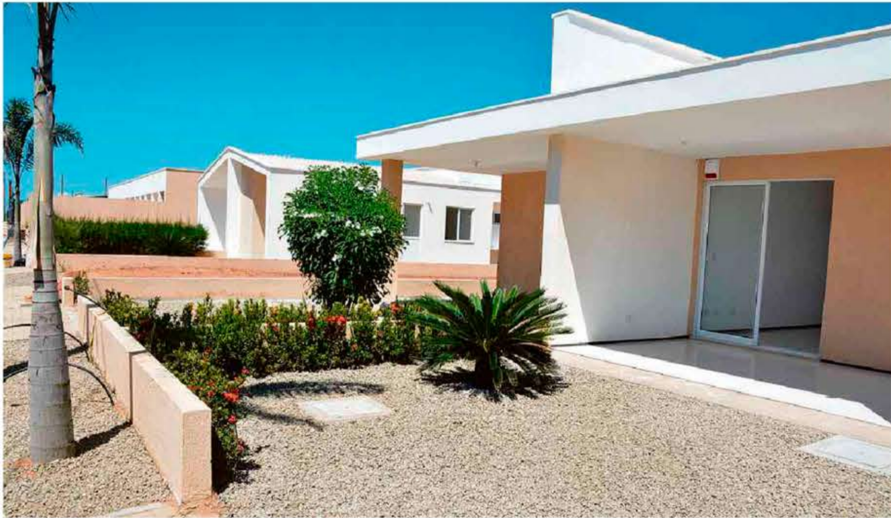
Casas da Smart City Laguna, localizada na cidade de São Gonçalo do Amarante, região metropolitana de Fortaleza (CE) Fotos Divulgação
